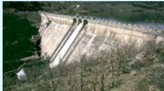
González Lacasa dam
